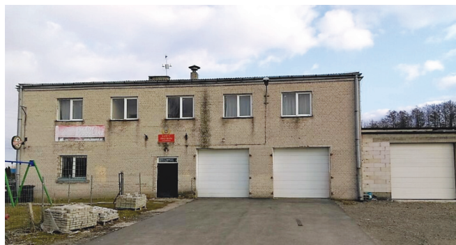
Budynek świetlicy wiejskiej wraz z remizą OSP w Minkowicach (fot. A. Zajczkowska)
