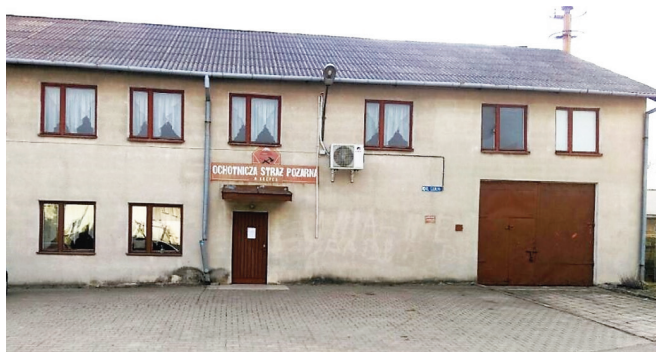
Budynek świetlicy wiejskiej wraz z remizą OSP w Krępcu (fot. A. Zajczkowska)
